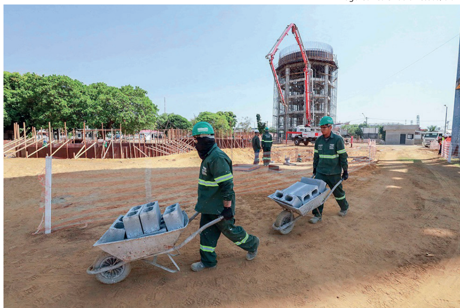
Entre as ações previstas para 2026, estão a conclusão dos quatro Centros de Reserva e Distribuição, com o primeiro a ser inaugurado em março, e o início das obras das 504 unidades habitacionais, de urbanização e de infraestrutura, até o fim de março
